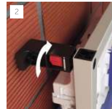
2 Прикрепите инсталляцию к полу и стене и отрегулируйте настенные крепежные скобы EasyFix™, убедившись, что инсталляция выровнена по уровню со стеной.
